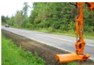
Профилирование обочин дорог для обеспечения надлежащего отвода воды с проезжей части в канаву.
